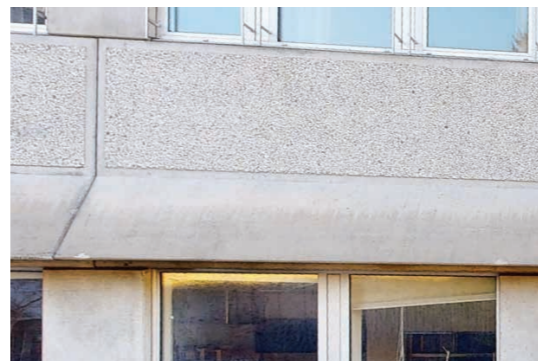
Betongelementer i fasade
